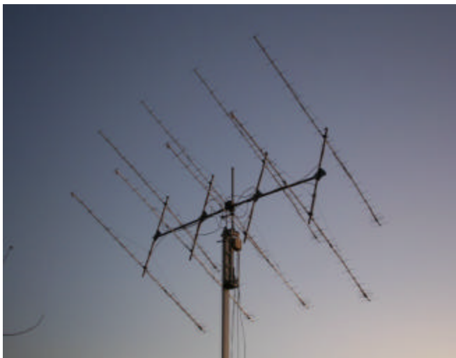
FR5DN's 70 cm 8 x 21 el F9FT yagi array
