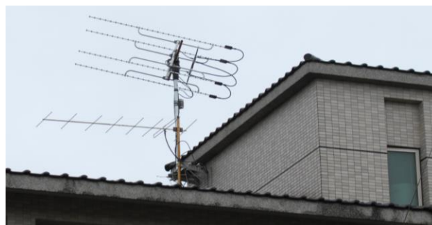
BV3CE 4 yagi 23 cm array
